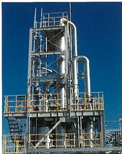
「溶剤回収装置」
