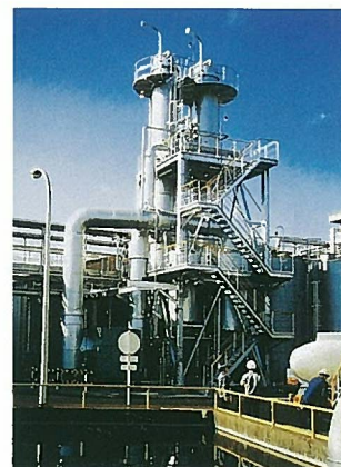
「蒸発濃縮装置（自己蒸気圧縮型）」
