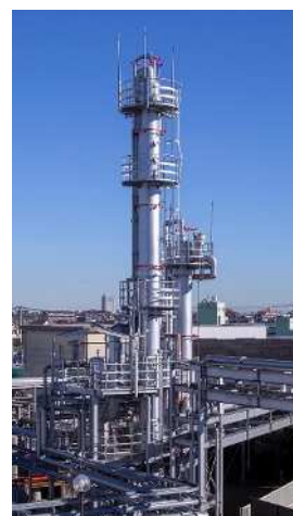
図 5. 省エネ型ヒートポンプ式蒸留装置 (名糖産業 八王子工場にて施工)
